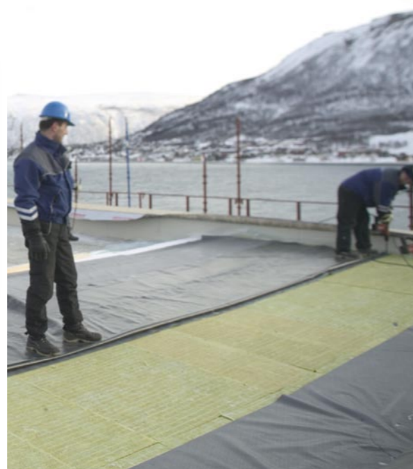
Som avsluttende tekking benyttes Protan takbelegg. Ofte i tilpassede størrelser som sikrer effektiv fremdrift og fabrikkveisede skjøter.
